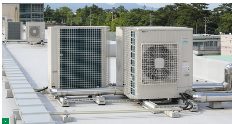
1 各教室の室内ユニットには「てんつり」を設置。2 各教室の空調は職員室の「適温適所mini」で集中管理。3 教室ごとに多機能リモコンを設置。オンオフと風量・風向の調節以外の操作は「適温適所mini」で制限。4 スペースの広い特別教室（写真は技工室）には「てんつり」を2台設置。5 室外ユニットには省エネ性を重視して「省エネの達人（R32）」を採用。防護ネットで安全性を確保。
